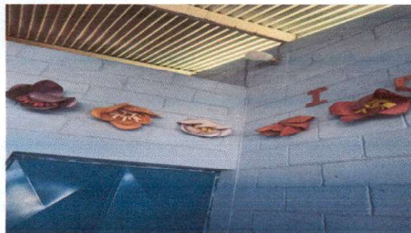
Foto 2: SUSTITUCION DE FOCOS AHORRADORES
