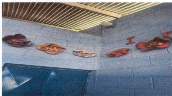
Foto1: SUSTITUCION DE FOCOS AHORRADORES
